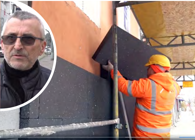
Czekamy, aby znalazły się pieniądze jeszcze na remont pomieszczeń w środku – mówi Jerzy Sobolewski
