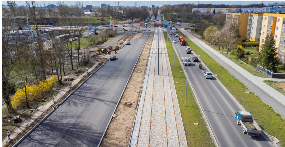
Na ul. Łukasińskiego, Zawackiej i Walczaka w Gorzowie są już położone drugie jezdnie drogi krajowej nr 22
