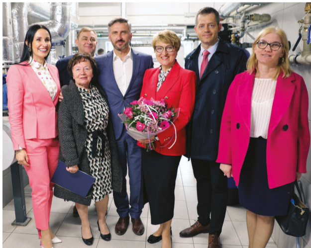
Szpital w Nowej Soli ma nowoczesną kotłownię. Inwestycja kosztowała blisko 16,7 mln zł, a wartość dofinansowania wyniosła blisko 13,8 mln zł
