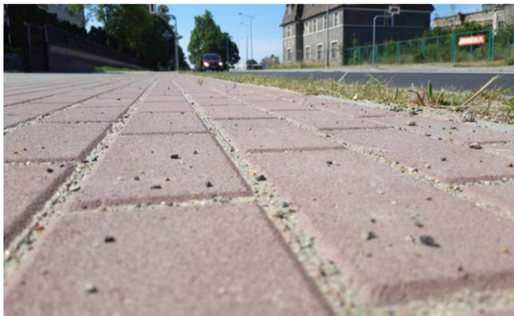
Przebudowa kosztowała ponad 6 mln zł.
