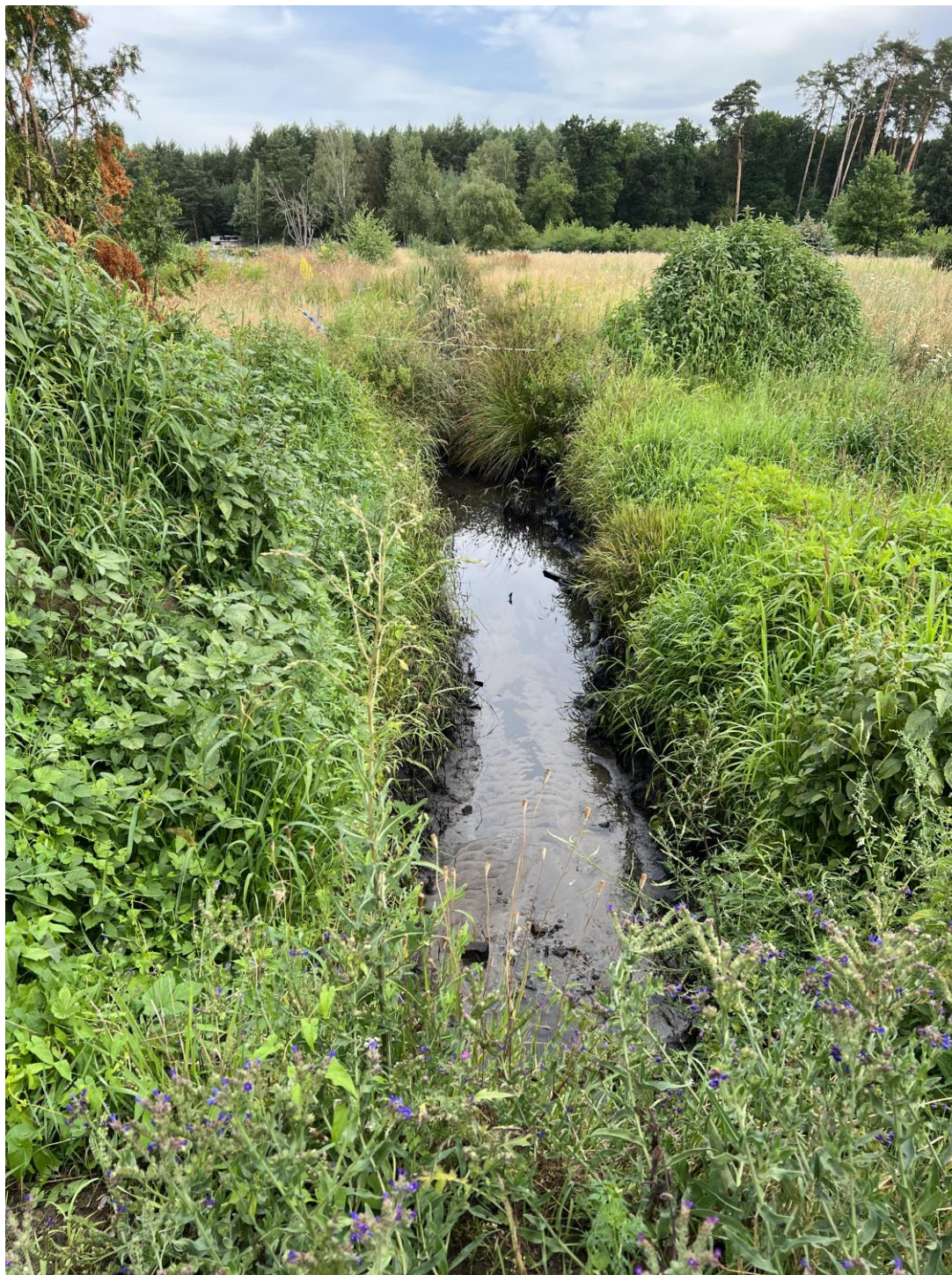
Fot. nr 6. Pusty kanał – łącznik ciek Gęśnik z kolektorem ks1200 - 26.VII.2023 r.
