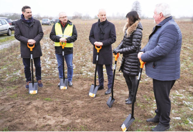
Pierwszą łopatę na budowie obwodnicy wbito pod koniec 2021 roku
