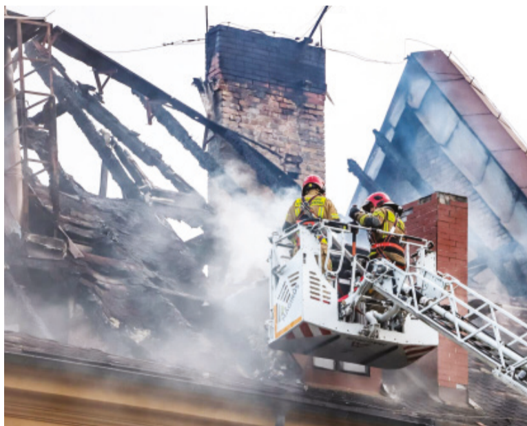
Budynki przy ul. Teatralnej mogą być wyłączone z użytku nawet przez kilka lat
